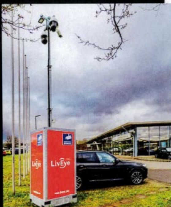
Zum sechs Meter hohen Videoturm gehören zwei PTZ- und eine bispektrale Bulletkamera. Sie detektieren Verdächtige(s) bis in 200 m Entfernung. Bild: LivEye
